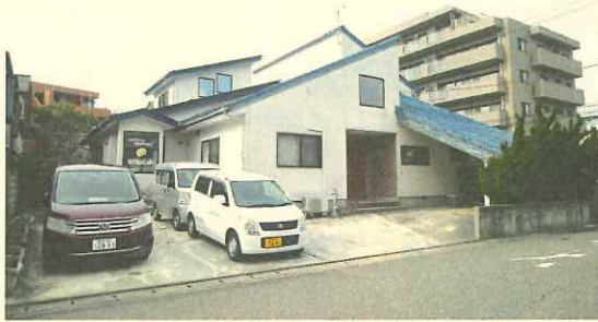
☆正面からの全体
